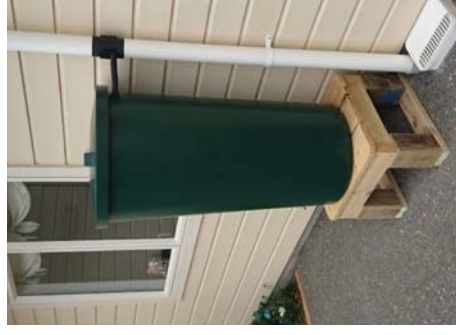
Fig. 19. WREMO 200L on a DIY rostrum.
