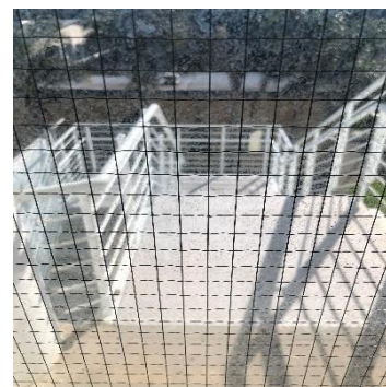
c) Reuse (reused stair)
